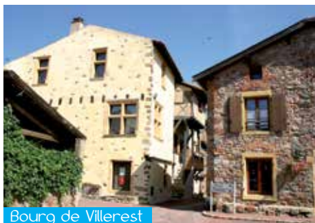
Bourg de Villerest
