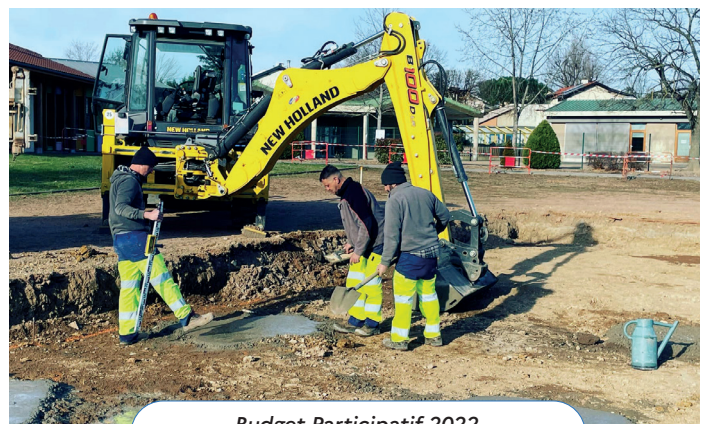
Budget Participatif 2022 Les travaux pour l'installation du futur parc de la Mirandole ont démarré.
